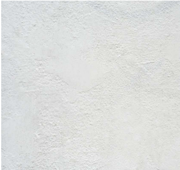
Vägg / Kalkputs borstad upp till 2,20 meter
