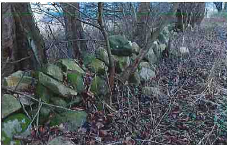
Stenmur längs Tångstigens södra sida
